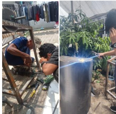
(b). Penyambungan besi siku dan pelat
